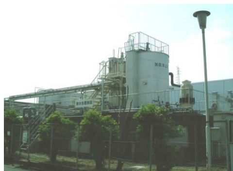
加圧浮上装置更新(鶴見工場)
