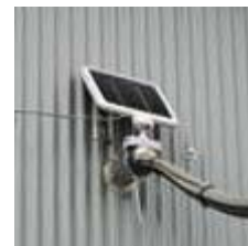
太陽光パネル
