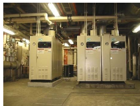
都市ガス燃料ボイラー(小山工場)
