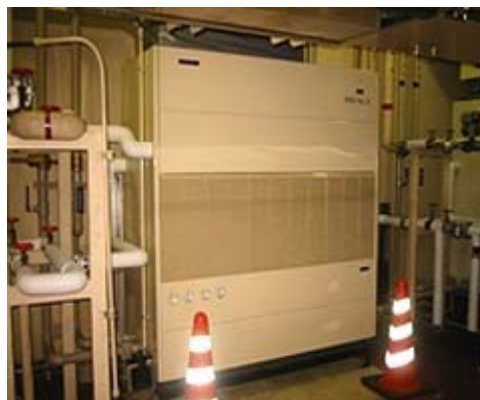
代替冷媒使用空調機(小山工場)
