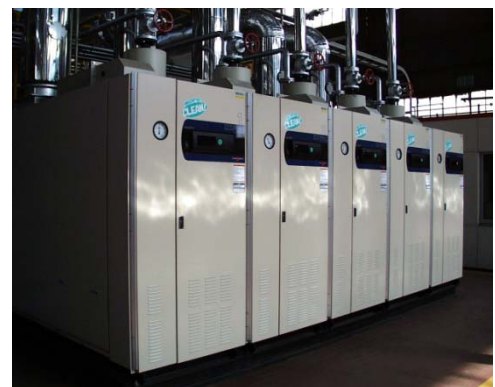
小型ボイラー(塚口工場)
