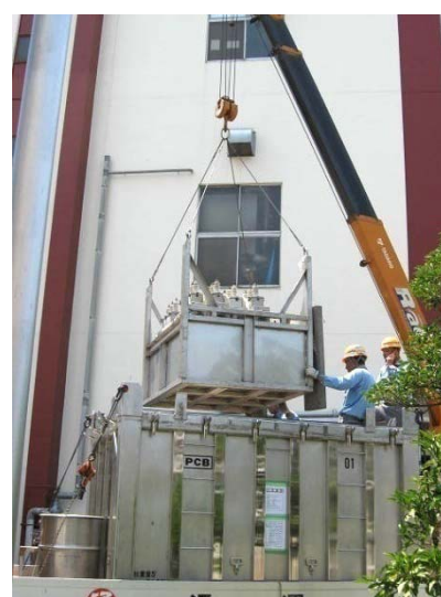
PCB収集運搬(中京工場)
